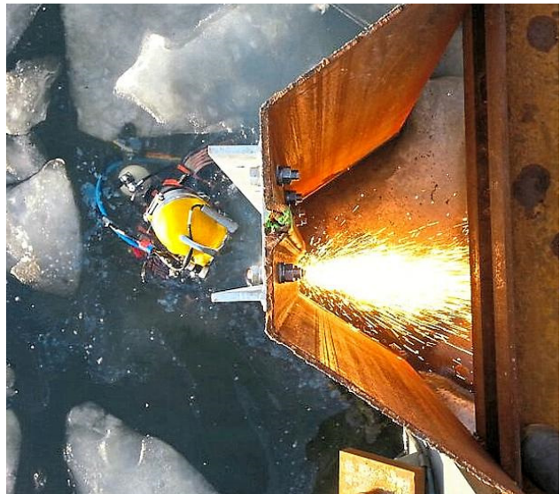
Eisgekühltes Schweißen: Alles, was Handwerker über Wasser können, kann Berufstaucher Stefan Frey auch in den kühlen Fluten.
